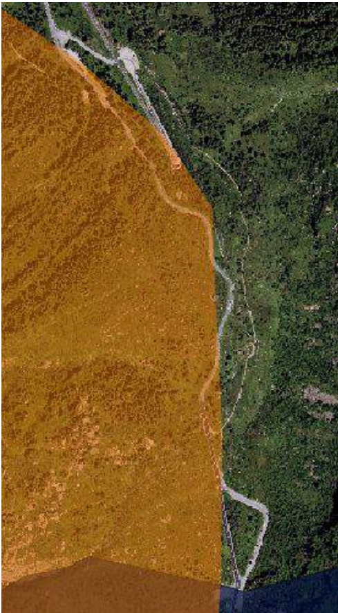
Infrastructures existantes à l’aval du col des Montets et périmètre du site Natura 2000 des Aiguilles Rouges
