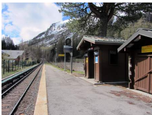
Halte ferroviaire et équipements périphériques existants
