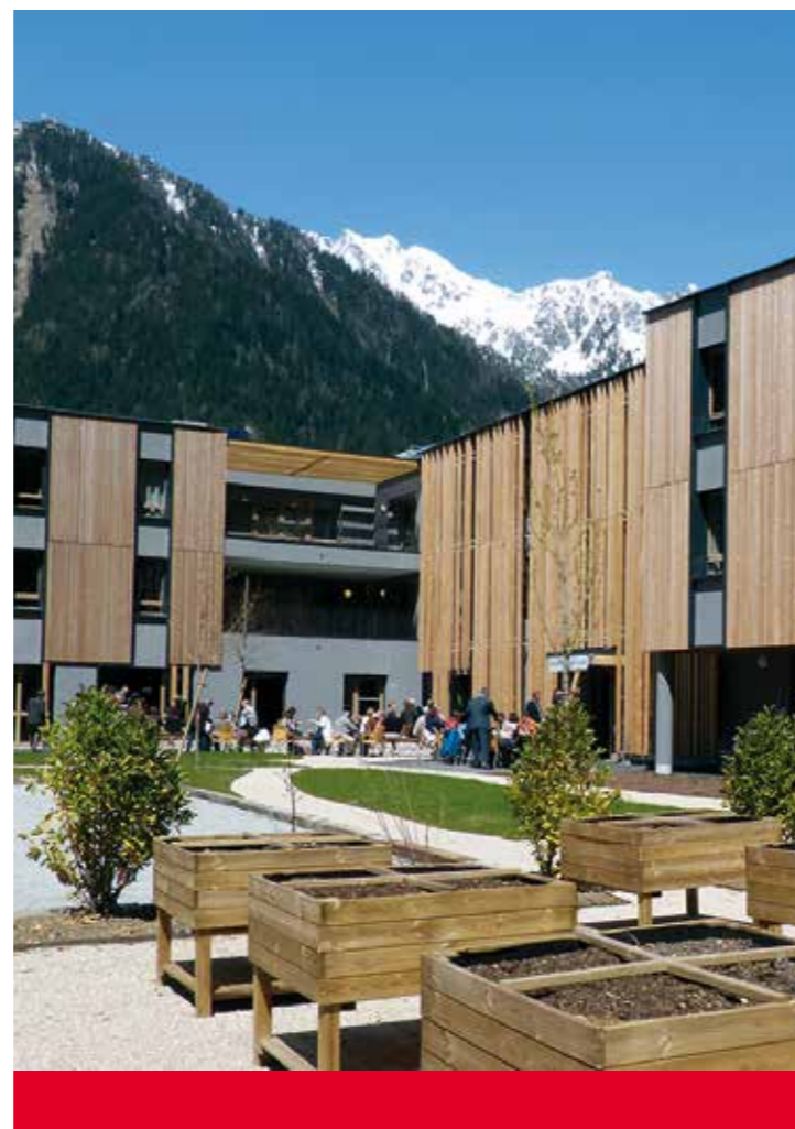
Etablissement d'hébergement pour personnes âgées dépendantes
