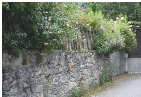
Mur bahut en pierre + clôture en bois à claire-voie - Les Houches
