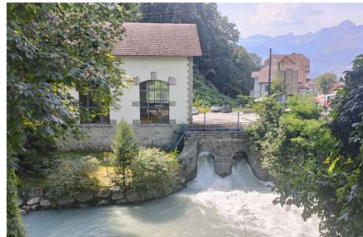
Centrale hydro-électrique du Fayet - Saint-Gervais-les-Bains
