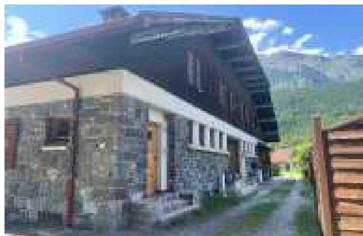
Chedde - Chemin d'accès en concassé
