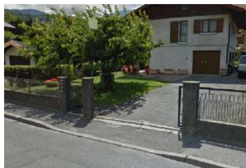
Mur bahut en béton + clôture métallique ajourée - Sallanches
