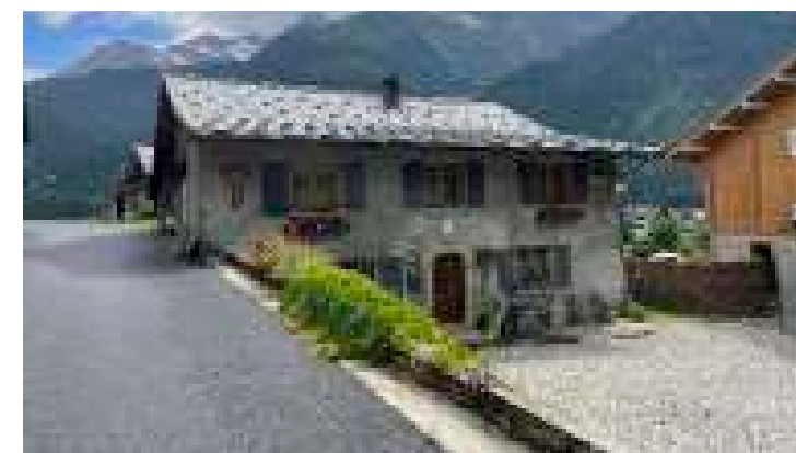
Le muret en pierre, la bande de béton et la grimpante débordante apportent une finition soignée à la chaussée en enrobé. Une règle avec l'enrobé, toujours s'arrêter avant pour dessiner une limite
