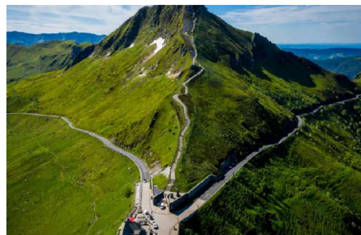
Maison de site - Puy Mary Grand Site de France (15) - 2007 - Bouchaudy Architectes
