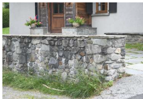
Muret en pierre route de la Griez - Les Houches
