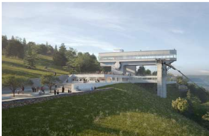
Réhabilitation de la gare du téléphérique du Salève - 2024 (Claudia et David Devaux)
