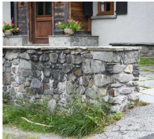
Muret en pierre / route de la Griaz - Les Houches
