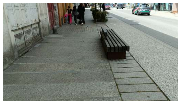
Calepinage de dalles granit Une pierre qui assure une très grande pérennité à l'aménagement et autorise un réemploi
