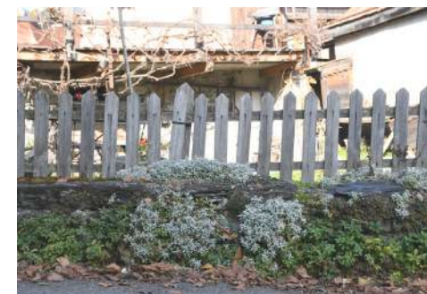
Clôture bois ajourée sur muret en pierre - Servoz
