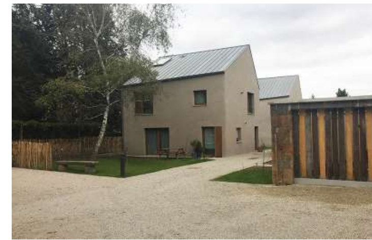
Oullins - Référence hors territoire - Rénovation et extension d'un bâti patrimonial et sa dépendance agricole. Petit collectif
