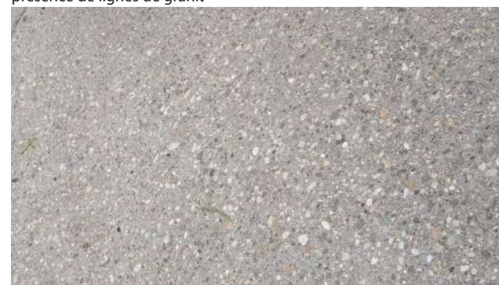
Béton sablé. La nature et la taille des granulats utilisés permettent différentes nuances
