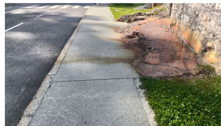
Béton balayé avec bordures granite noyées. Cette finition de béton est économiquement intéressante. Elle est rendue plus précieuse par la présence de lignes de granit
