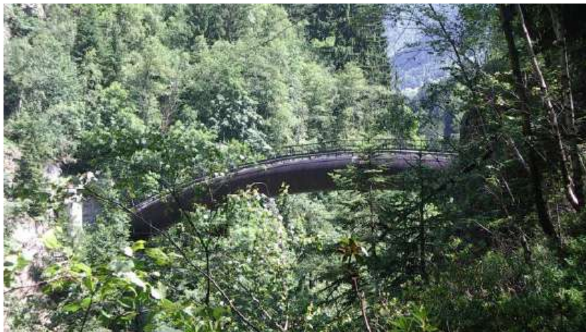
Conduite forcée du Siphon de l'Arve - Les Houches
