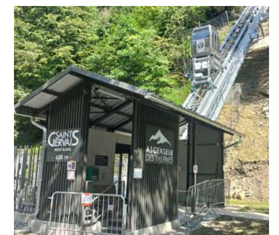
Ascenseur hydraulique - Saint-Gervais-les-Bains
